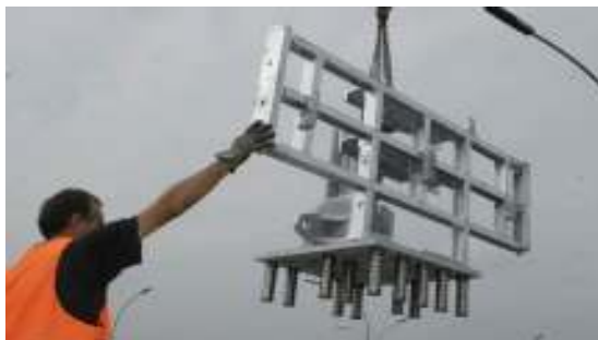
Figura 7 – Inserimento pilette nel supporto posteriore
