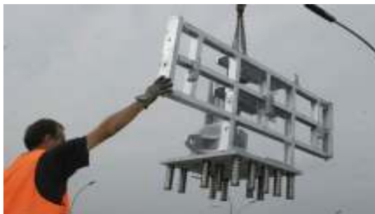
Figura 7 – Inserimento pilette nel supporto posteriore
