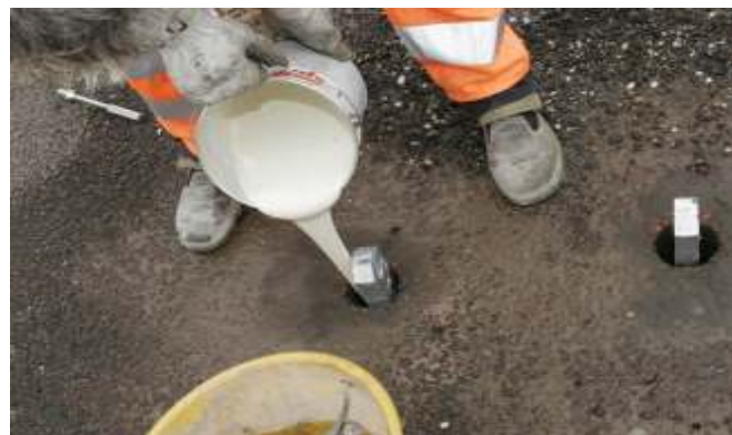
Figura 3 - 4 – Inserimento palo d'ancoraggio
