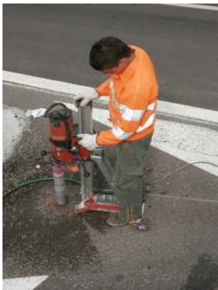
Figura 2 – Carotatura per i pali d'ancoraggio
