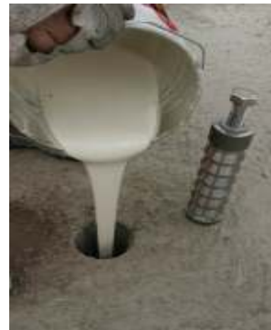
Figura 5 - 6 Preparazione fori per supporto posteriore
