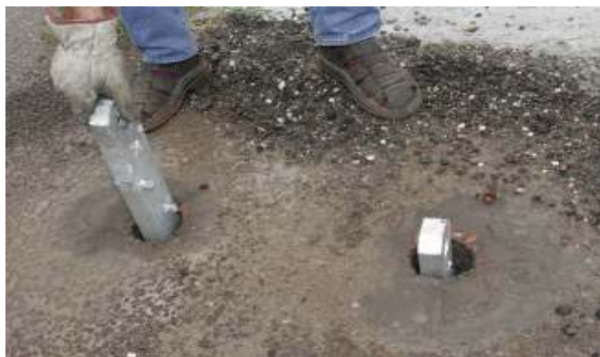
Figura 3 - 4 – Inserimento palo d'ancoraggio
