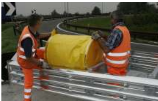
Figura 28 – Alloggiamento bag
