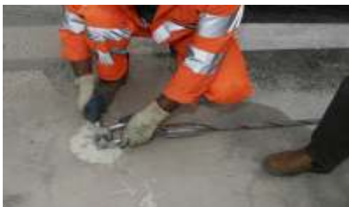
Figura 17 - 18 – Collegamento funi a pali d'ancoraggio
