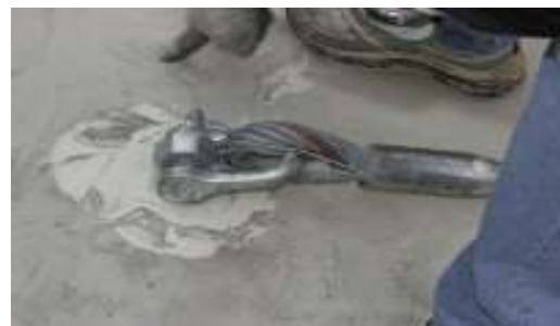
Figura 17 - 18 – Collegamento funi a pali d'ancoraggio
