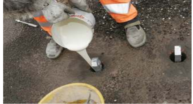
Figura 3 - 4 Inserimento palo d'ancoraggio
