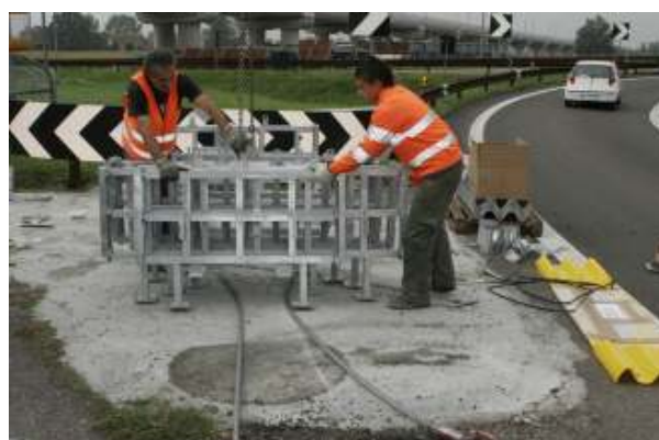
Figura 11 - 12 – Posizionamento supporti intermedi
