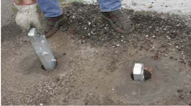
Figura 3 - 4 Inserimento palo d'ancoraggio
