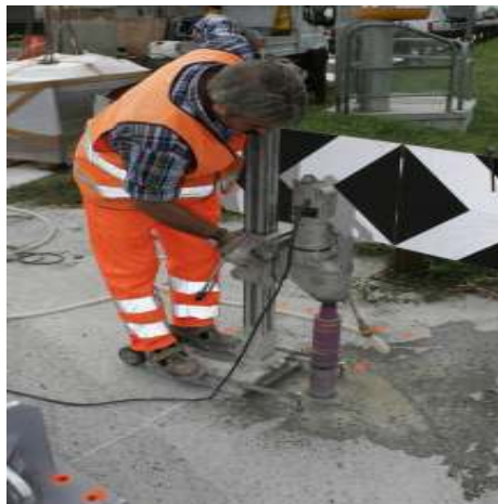
Figura 5 - 6 Preparazione fori per supporto posteriore
